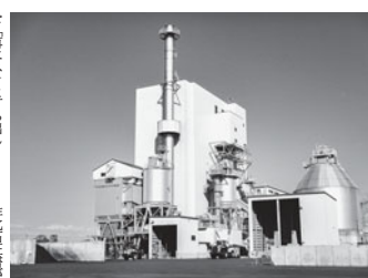
ドック電力が今春まで電力調達していたバイオマス発電所
